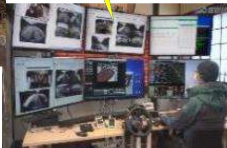
遠隔監視・操作室
