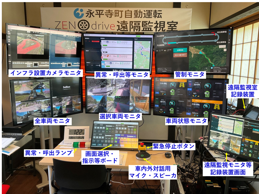
レベル4 自動運転移動サービス用遠隔監視室
