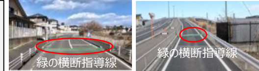
バス停内: 9 単独: 6 *注 横断指導線とは、歩行者が道路を横断する場所を示す施設で、道路法に基づいて道路管理者が設置する区画線である(横断歩道は道路交通法に基づいて都道府県公安委員会が設置する道路標示である)
