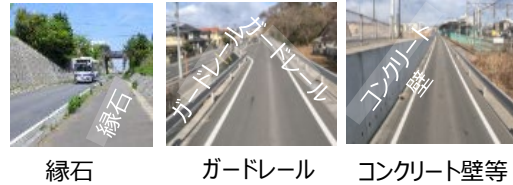
縁石 ガードレール コンクリート壁等
