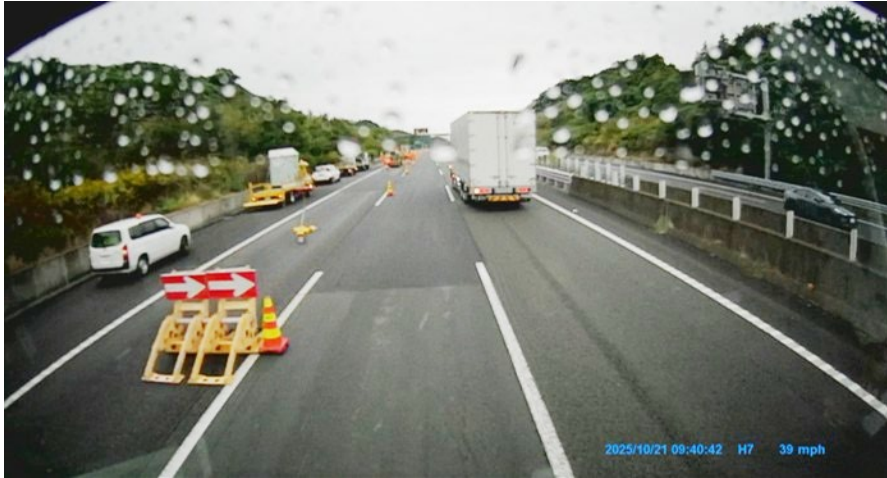
パイロンはみ出し(車線幅2.75m、車幅2.5m)
