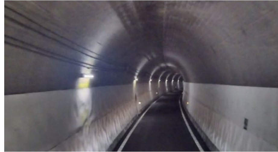
気仙沼BRT路トンネル（最長約4 km）
