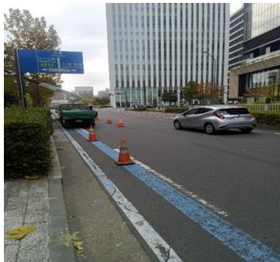
乗降地：ブルーアベニュー前で実施されていた植栽伐採作業
